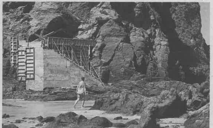
Los trabajos se realizan con marea baja | JORGE MEIS
