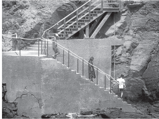
Las escaleras están realizadas en madera y hormigón | JORGE MEIS
