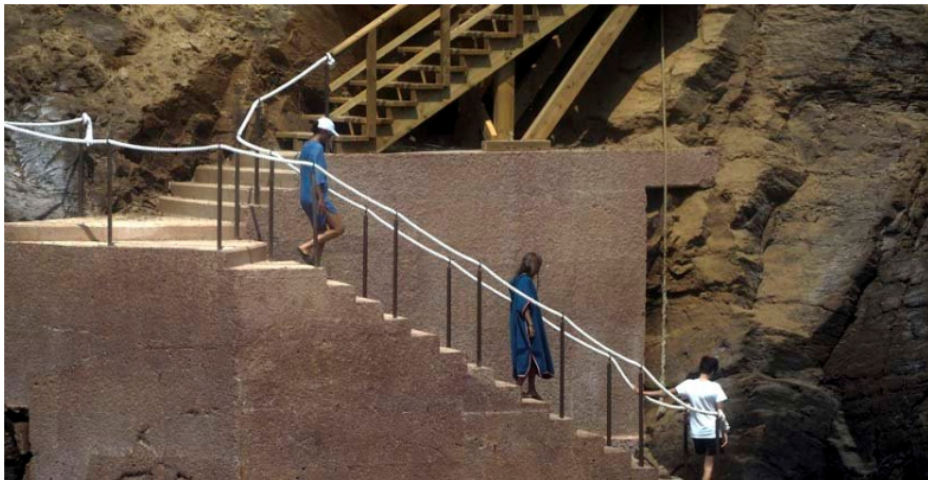
Las escaleras están realizadas en madera y hormigón | jorge meis
