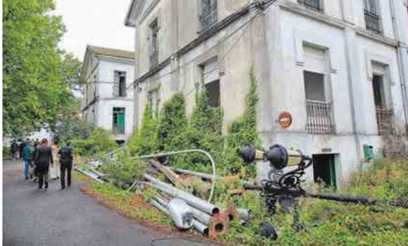
Un cajón de sastre entre maleza y residuos. Báculos de farolas, piedras, desechos y otros residuos copan el exterior y el interior de los edificios repartidos por el recinto. FOTOS JOSÉ PARDO
