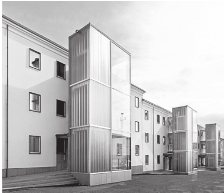
Ascensores exteriores del cuartel de la Guardia Civil en Catabois
