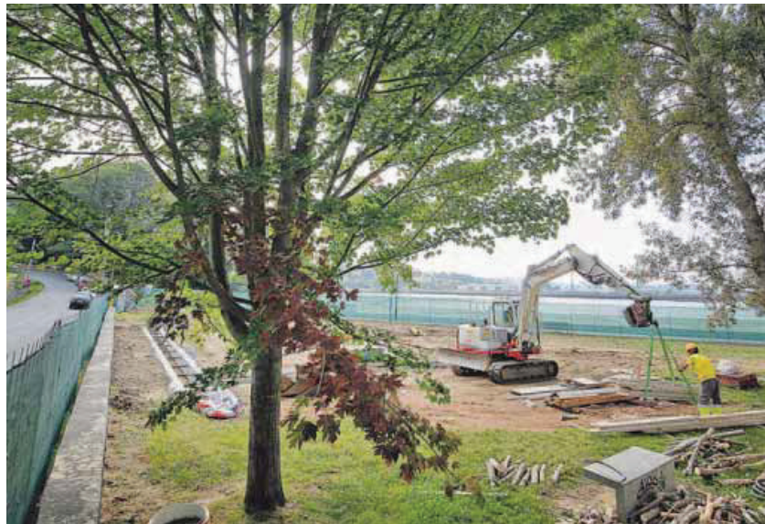
Trabajos de la nueva instalación de saneamiento en la zona del parque de A Cabana. JOSÉ PARDO
