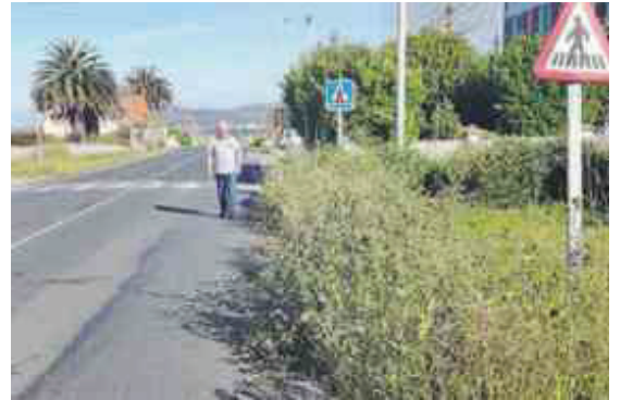
La maleza obliga a los peatones a caminar por la calzada.
