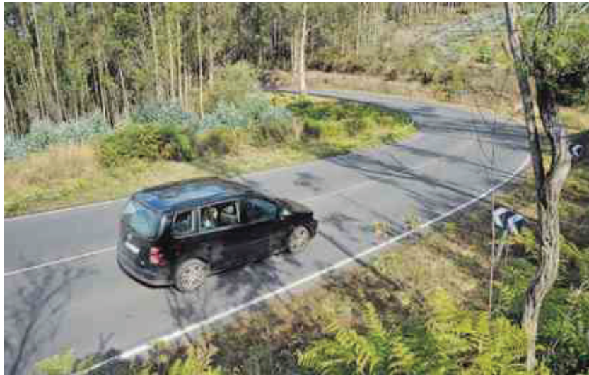
Curva de San Pedro, en la carretera de Covas, donde se registran continuas salidas de vía. ESTEVO BARROS
