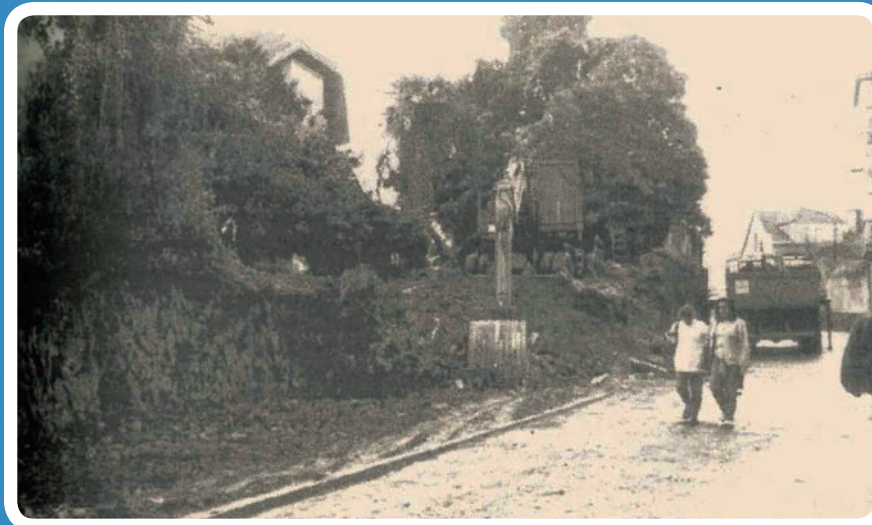
Comenzó el derribo del muro de la calle Alegre tras el traslado de varios árboles | ARCHIVO
