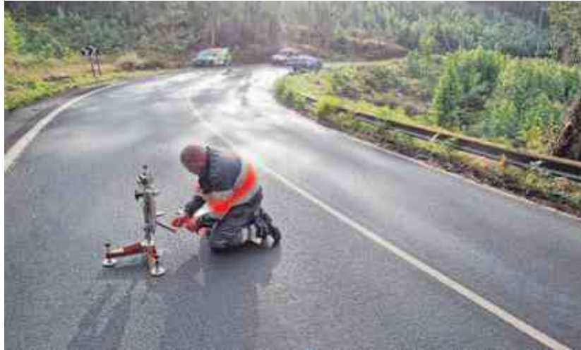
Operario realizando pruebas sobre el asfalto ayer en la carretera de Ferrol a Covas. JOSÉ PARDO
