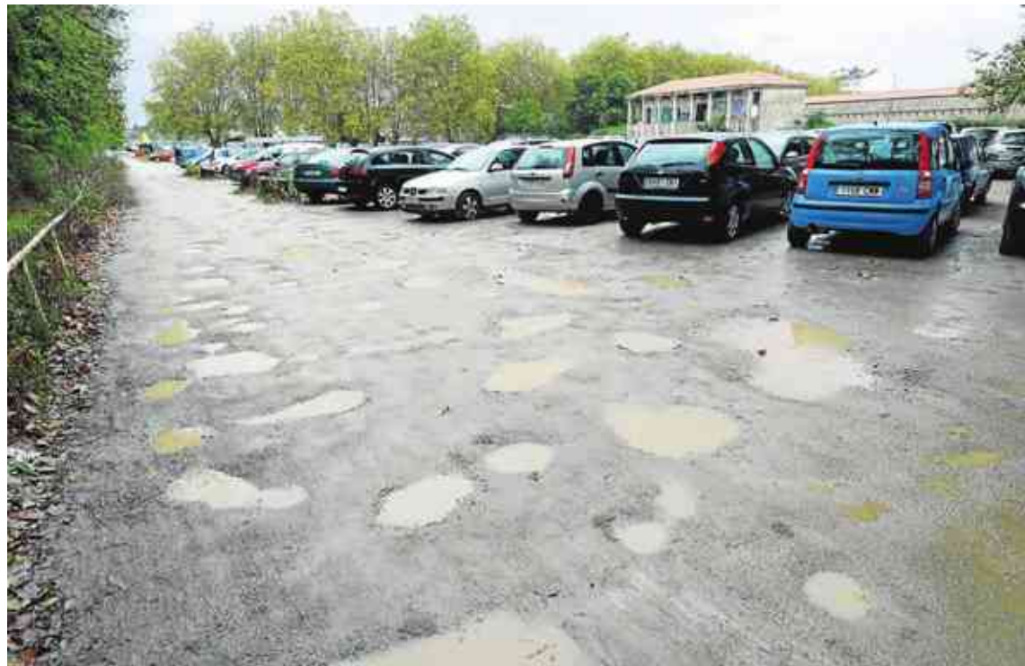
Los socavones en el Sánchez Aguilera han hecho acto de presencia solo 20 días después de su reparación | DANIEL ALEXANDRE
