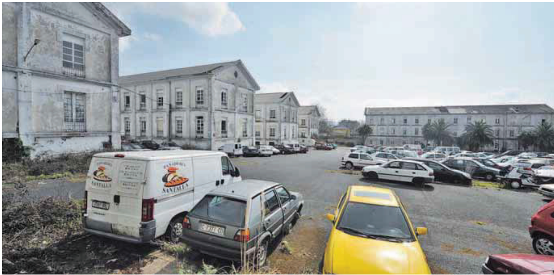
Imagen de parte de las instalaciones del antiguo cuartel Sánchez Aguilera, la pieza principal del convenio con Defensa. ÁNGEL MANSO
