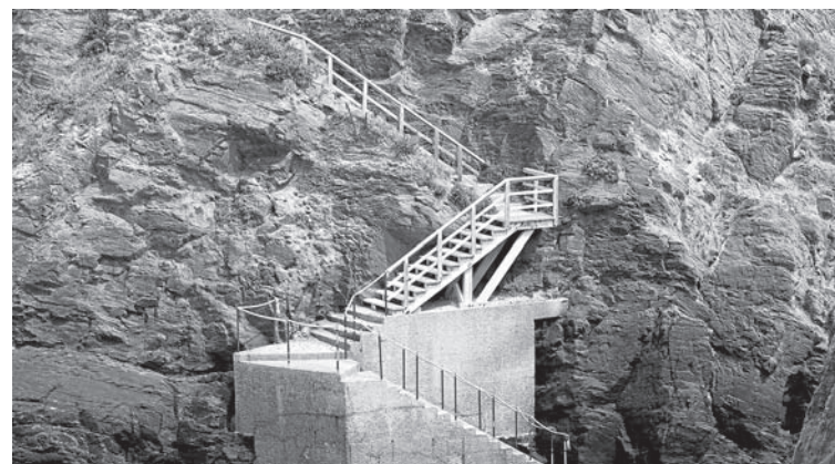
Las escaleras de acceso a la ermita de Santa Comba repondrán elementos | J.MEIS
