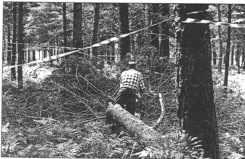
Un operario tala árboles en el lugar en el que se construirá el futuro campo de golf. MIGUEL RIOPA
