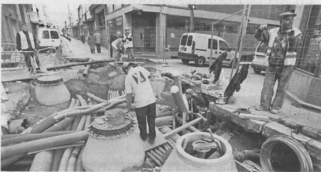
El cruce con Tierra lucía ayer este aspecto en obras, aunque está previsto que abra al tráfico mañana | CÉSAR TOIMIL
