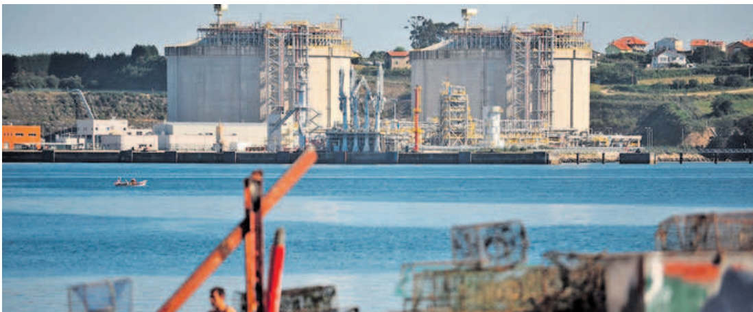
La planta de gas de Reganosa cuenta con dos tanques de almacenamiento y puede registrar cargas y descargas de buques. ÁNGEL MANSO
