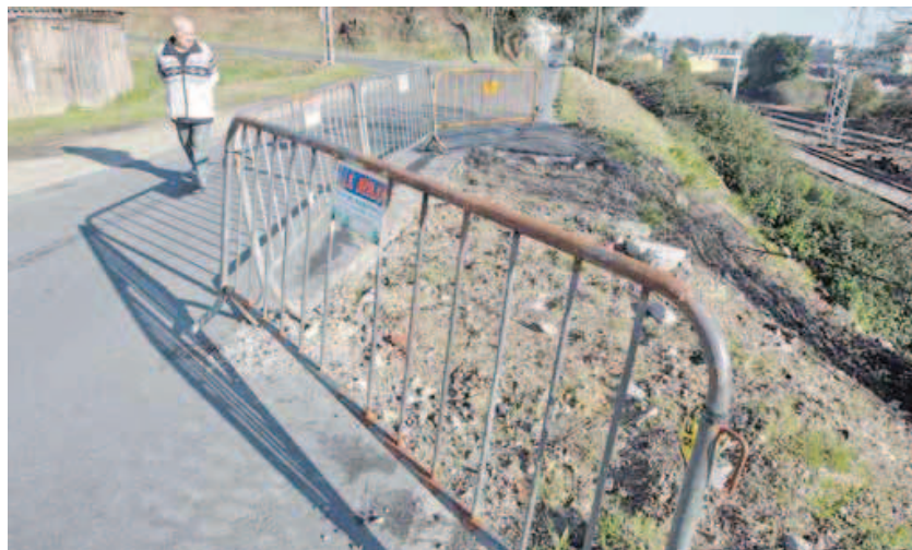
En la imagen se aprecia cómo el nuevo desmoronamiento se ha comido parte de la calzada. CÉSAR TOIMIL
