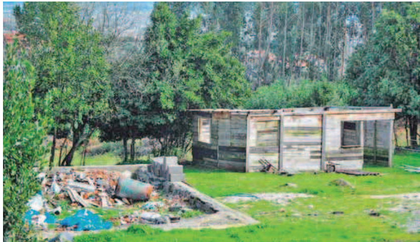
Construcciones de madera y bases de hormigón continúan en el lugar de Cal da Regueira. ÁNGEL MANSO
