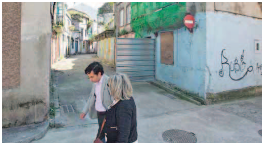
Roban una valla en Carmen Curuxeiras. El alcalde paseó por el barrio y pudo comprobar cómo ha desaparecido una de las hojas de aluminio del cierre de la calle, blindada por peligro de desplomes. La valla se abrió hace unos días para reparar una fuga de agua y alguien se la llevó. JOSÉ PARDO
