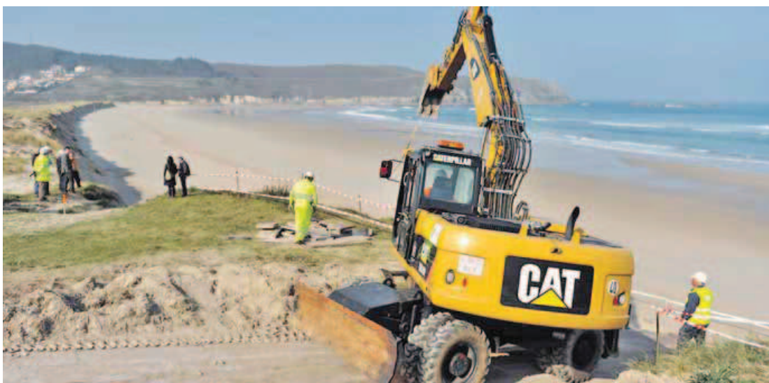
En la playa valdoviñesa de Pantín los trabajos consisten en la restauración del puente y la rampa de acceso por un nuevo trazado. ÁNGEL MANSO
