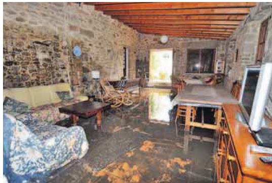
Interior de la casa con el suelo embarrado y filtraciones de agua. A.M.
