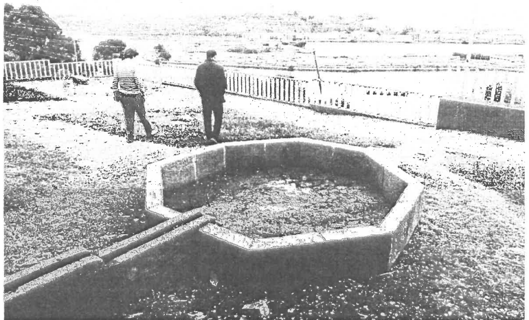
El estanque está vacío en verano. Junto a la valla se advierte la depresión causada por el agua
