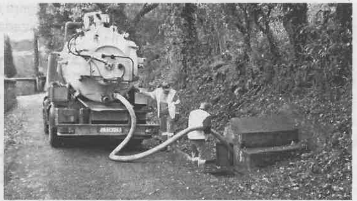
Operarios procediendo ayer a la limpieza de la fuente en Pazos
