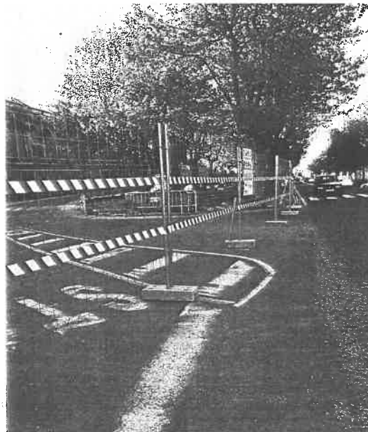
La cuesta de Mella, ayer, tras quedar vallada para iniciar las obras | ARI GARCÍA
