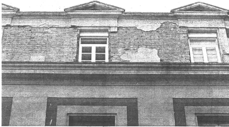
Así estaba ayer la fachada del palacio municipal que da a la calle Rubalcava | MARCOS CREO
