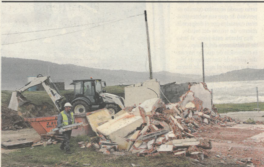
Un operario trabaja en las tareas de demolición del bar Playa, ayer por la mañana | ÁNGEL MANSO
