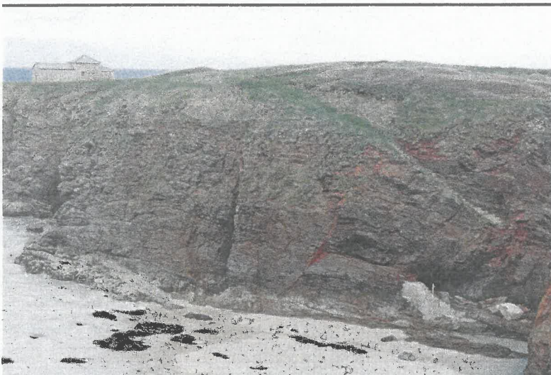
La lluvia y el viento han destruido parte de la escalera de acceso al templo
